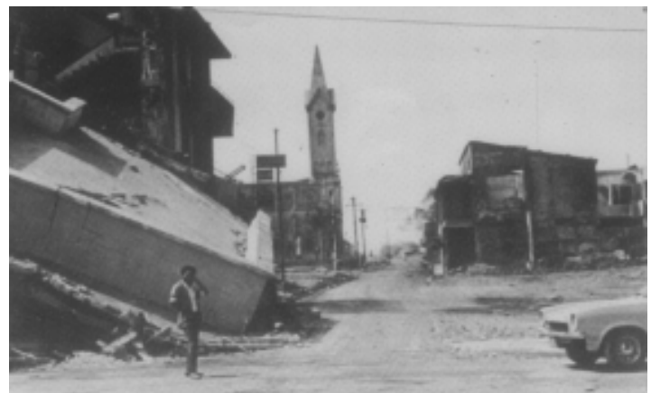
Edificio de la Farmacia San Antonio - Al fondo la Basílica Menor de San Antonio, con su estructura completamente destruida.
